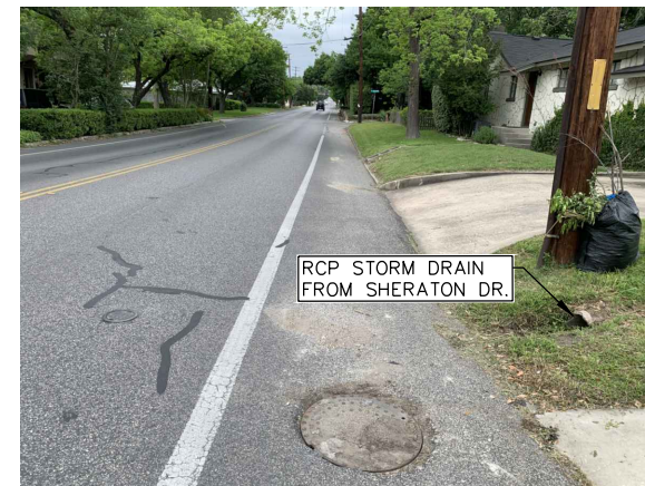
G STA. 8+10 M.H. A1 (#8050) (D.S. VIEW)
